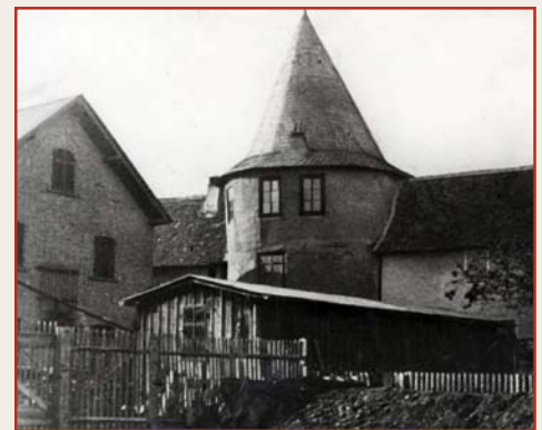
Synagoge zw. 1892 und 1908, li. Gebäude der Lederfabrik Engelhard, ab 1897 Neumann
