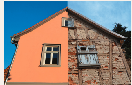
Links restaurierte Fassade, rechts freigelegtes Fachwerk während der Arbeiten
