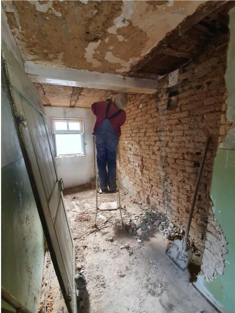
Entfernen des alten Putzes im Flur Foto: Andreas Friedrich
