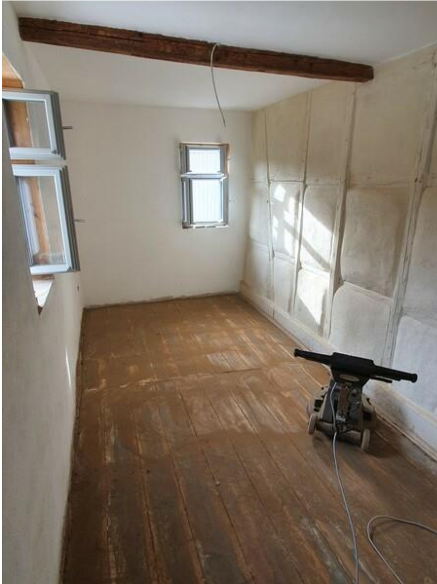
Schicht für Schicht wurden alte Farben abgeschliffen Foto: Andreas Friedrich
